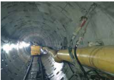
도봉의정부간 한전전력구세미실드 백필
