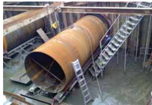
거제도 가스관 추진 시공
