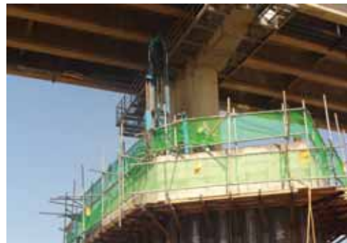
구미 낙동강 30공구 교각기초보강
