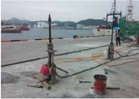
부산 감천항 부두 기초 보강공사
